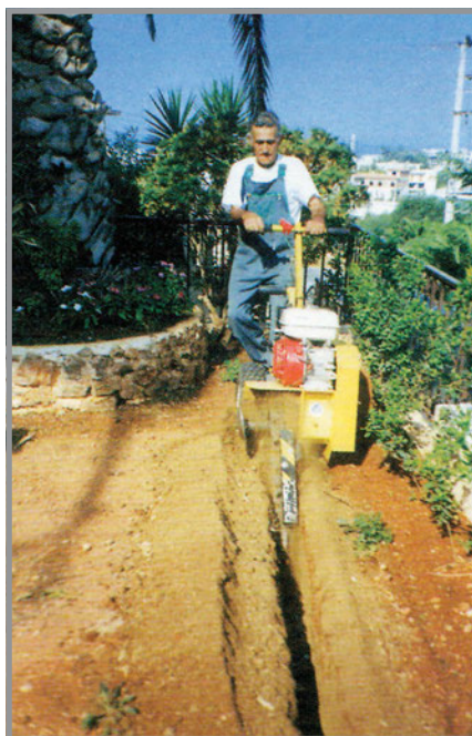
Εικόνα 14.3 Μηχανική διάνοιξη χαντακιών.
